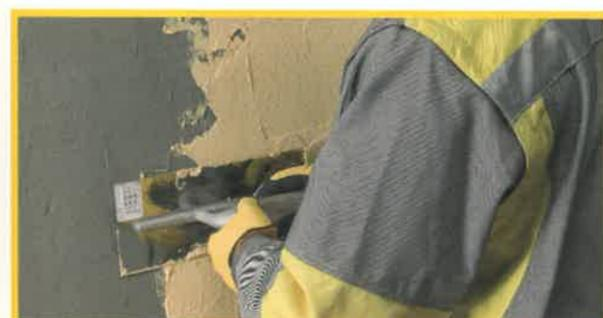
Dopo l'asciugatura completa della seconda mano di rasante, applicare una mano di primer che abbia la funzione di ponte di aderenza tra il rasante e il rivestimento (strato di finitura).
